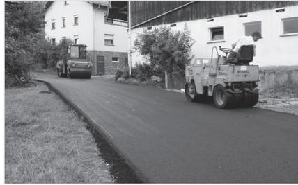
Mitte August wurden in Plesten sämtliche Straßen mit einer neuen Deckschicht überzogen. Dies wurde notwendig, nachdem 2008 die Kanalbauarbeiten durchgeführt wurden und 2009 die Stadtwerke die Versorgungsleitungen neu verlegt haben. Die Kosten teilen sich die Stadt Neustadt b. Coburg und die Stadtwerke Neustadt.
