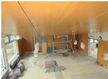
Größtenteils wurden die Systemtrennwände mit Einbauschränken errichtet.
