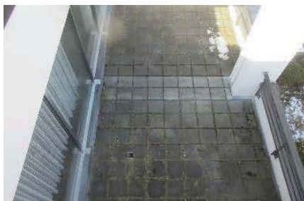
Dachterrasse vor der Sanierung
