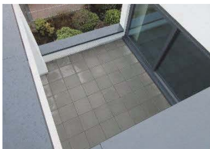
Dachterrasse nach der Sanierung
