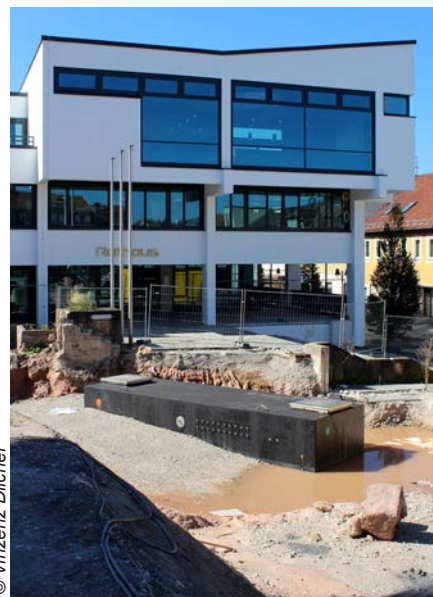
Der große schwarze Kasten beinhaltet Pumpenkammer und Wasserreservoir.
