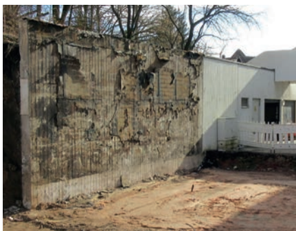
Gleiche Stelle nach dem Abriss
