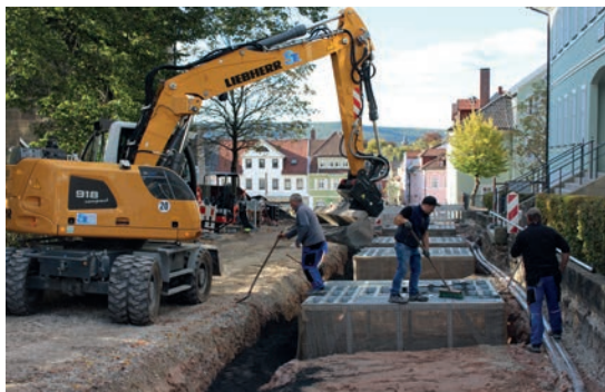
Der Einbau von großen Unterflur-Baumrosten erfolgte Anfang Oktober
