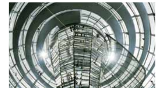
Im Berliner Reichstag mit verbaut: Kabel aus Neustadt
