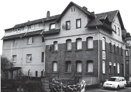
Das Haus vor der Sanierung....
