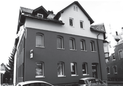
...und nach den Umbaumaßnahmen.
