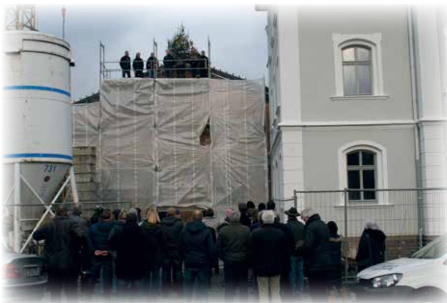
Richtspruch durch die Zimmerei Bauer, Herr Stubinger, Burgkunstadt
