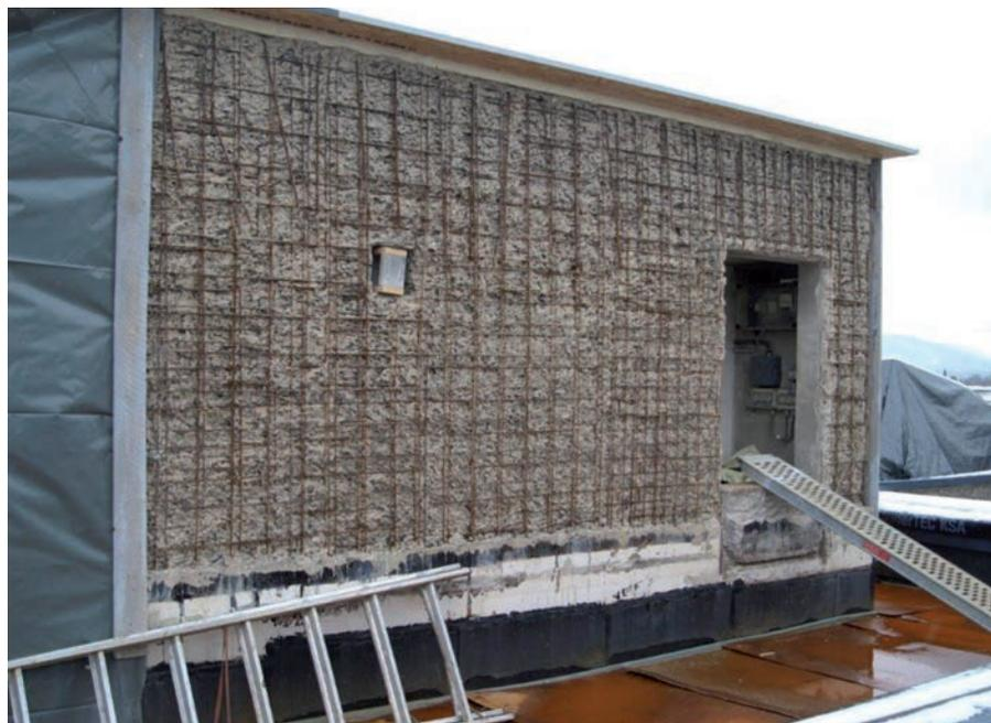
Die Rückbaumaßnahmen, also die Beseitigung überalterter oder desolater Bauteile im Bereich der Außenhülle des Gebäudes und im Inneren des Rathauses, wurden bereits im vergangenen Jahr abgeschlossen. Ebenso konnten die sehr lärmintensiven Abstrahlarbeiten der Sichtbetonoberflächen der Außenfassaden des Rathauses beendet und die anschließenden weiteren Sanie-
