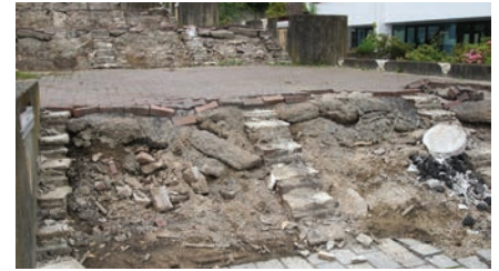
Auch die alte Treppenanlage muss der neuen Platzgestaltung weichen. Die alten Pflastersteine wurden ausgebaut und werden nun fachgerecht entsorgt.
