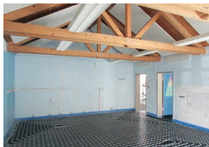
Neu verlegte Heizleitungen in einem Gruppenraum
