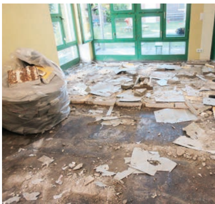
Beseitigung der durchnässten Dämmung
