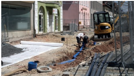
Bauarbeiter verlegen neue Rohre, bevor die neue Unterkonstruktion eingebaut wird.
