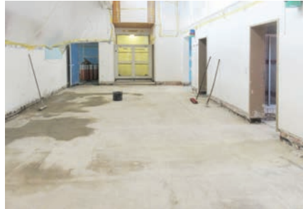
Freigelegte Bodenplatte
